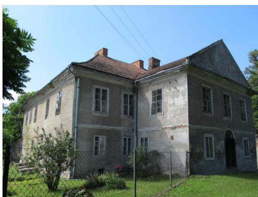
Fot. 5. Dwór w Skrzydłej
