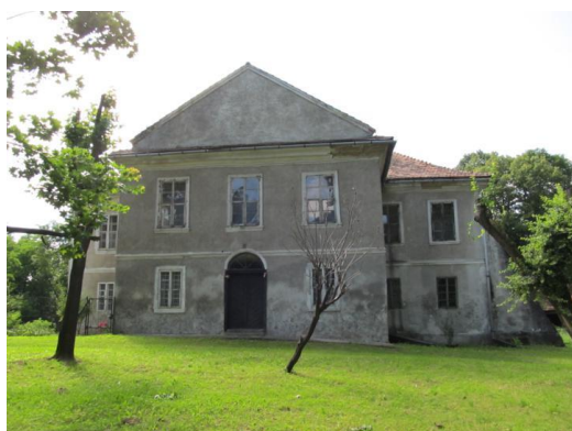
Fot. 4. Dwór w Skrzydłej
