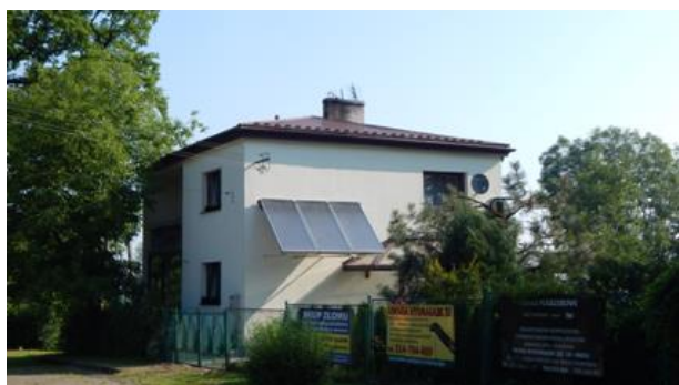
Fot. 1. Zabudowa mieszkaniowa, Skrzydlna
