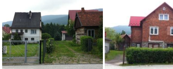
Zabudowa mieszkaniowa murowana i drewniana
