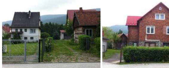
Zabudowa mieszkaniowa murowana i drewniana
